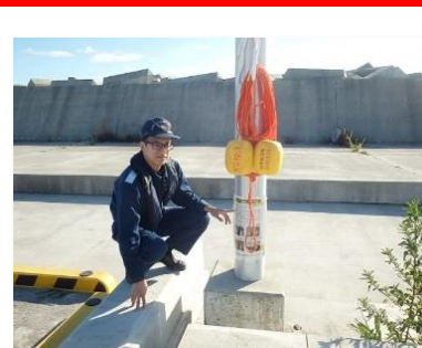
簡易救助器具の設置
